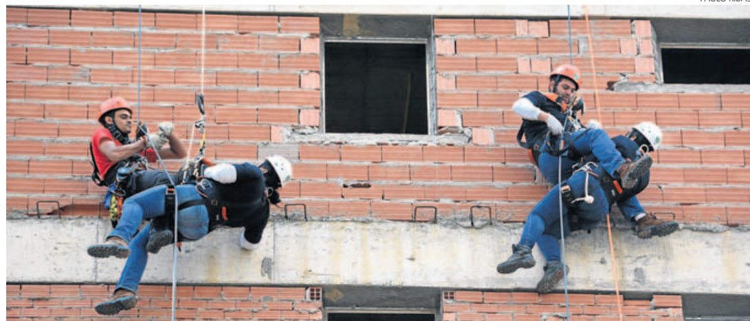
"ABRIL VERDE". Operários de construtora simularam resgate de trabalhador em obra de edificação vertical
