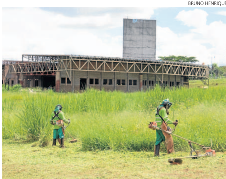
CORTE. Trabalho de limpeza executado pela Solurb será reduzido
